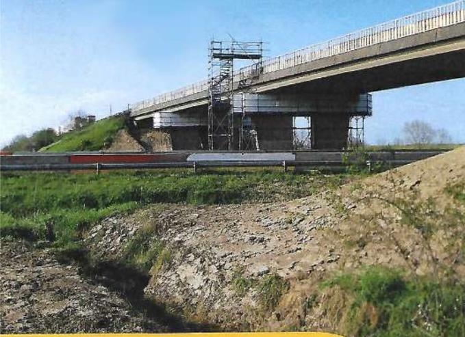
L'opération de vérinage et de remplacement des appareils d'appui d'un pont ou d'un viaduc vise à maintenir l'ouvrage en bon état et à garantir la sécurité des usagers.
