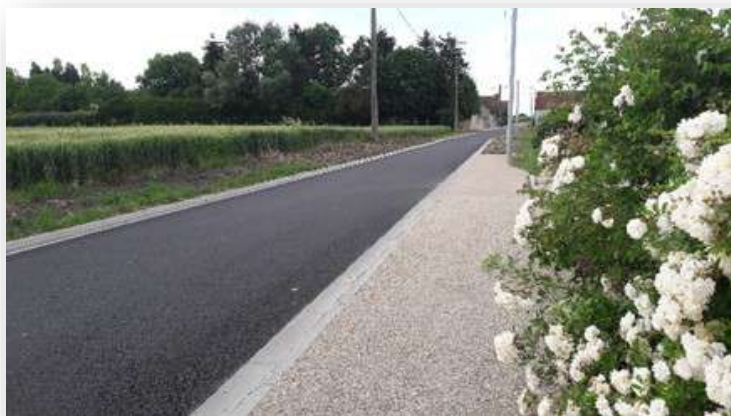
Rue de Châtre
